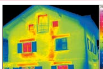
Strata ciepła ściany szczytowej
