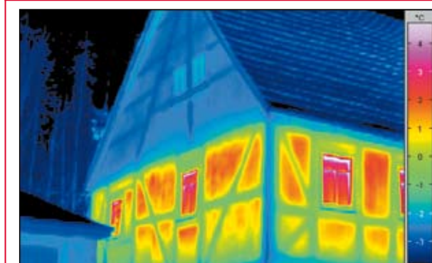
Otynkowany mur pruski
