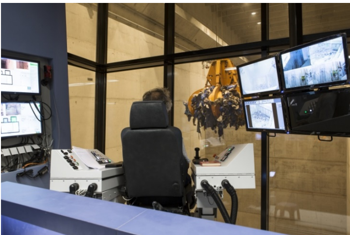
Abb. 3: In der Krankanzel haben die Kranführer jederzeit Zugriff auf alle zentralen Funktionen des Infrarot-Überwachungssystems WASTE-SCAN. Beispielsweise können sie von dort aus einzelne Kameras gezielt manuell steuern.
