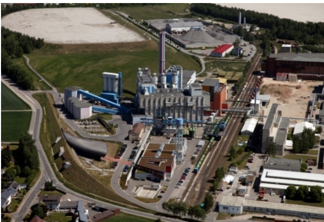
Abb. 1: Gesamtansicht ZMS Müllkraftwerk Schwandorf
