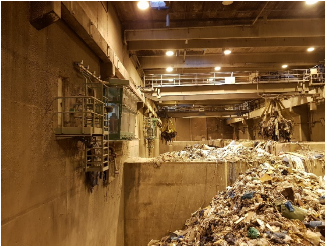
Abb. 2: Bunkeransicht mit Krankanzel links
