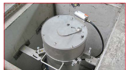
IR-Kamera im speziellen Schutzgehäuse zur Messung nach dem Pressen
